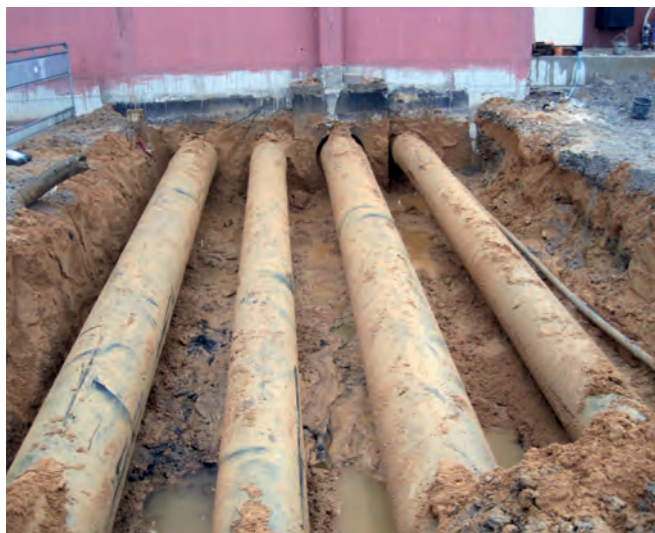
Freigelegte Fernwärmeleitung ▼
