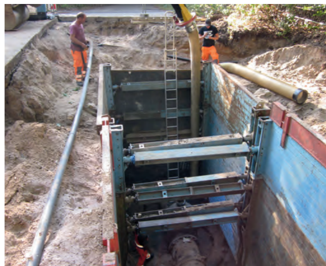
▲ Freilegen einer Wasserleitung
