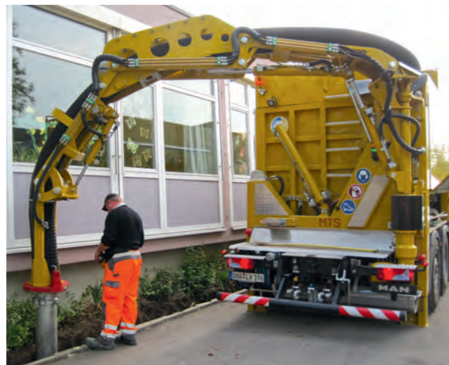
▲ Freilegen einer Wasserleitung
